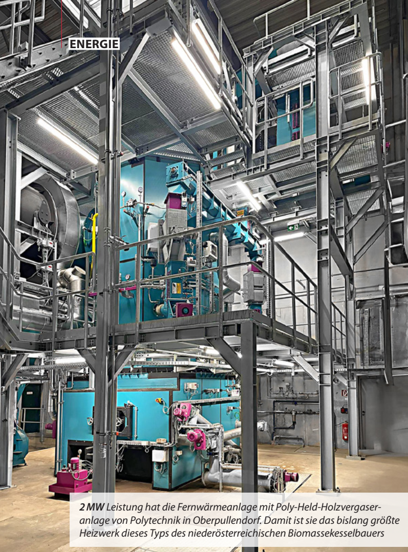
Zwei Monate Bauzeit: Das Heizwerk konnte rasch montiert und im Herbst des Vorjahres in Betrieb genommen werden. Eine zweite, baugleiche Anlage kann bei steigendem Wärmebedarf ergänzt werden
